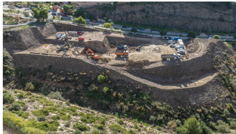
Ejecución del Parque de Bomberos, Central de Emergencias y Sede del Consorcio Provincial de Bomberos en el Rincón de la Victoria, Málaga (importe aprox. 3.800.000,00€)
