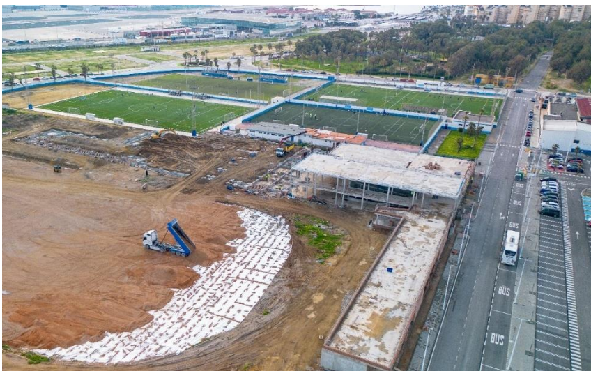
Ejecución del Complejo Polideportivo Municipal en La Línea de la Concepción, Cádiz (importe aprox. 7.000.000,00€)
