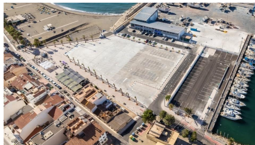
Reordenación de la zona de levante del Puerto de Caleta de Vélez, Málaga (importe aprox. 1.500.000,00€)
