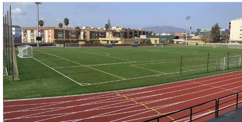
Desmantelamiento e impermeabilización del campo futbol en Complejo Deportivo Elola de Fuengirola, Málaga (importe aprox. 1.500.000,00€)
