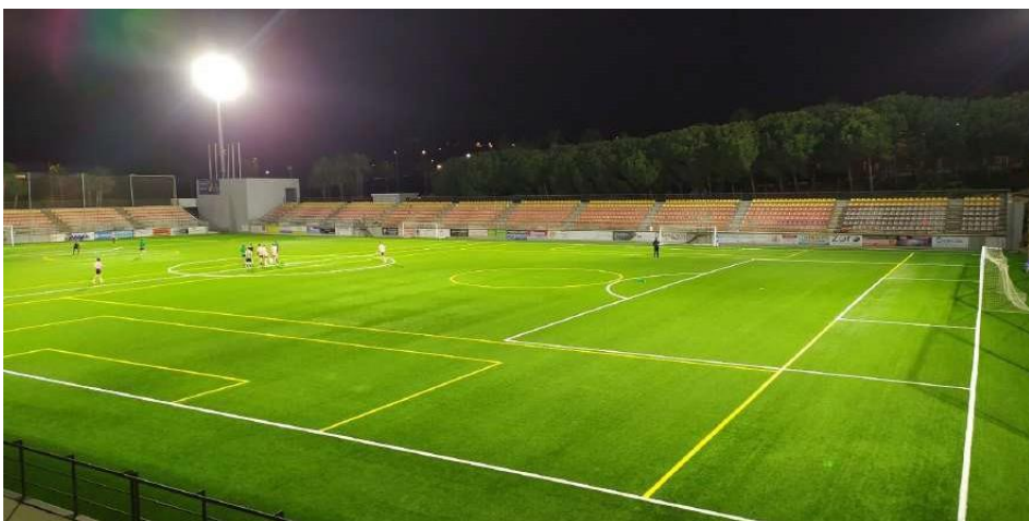
Campo futbol de césped artificial e iluminación en Estadio Muñoz Pérez de Estepona, Málaga (importe aprox. 325.000,00€)
