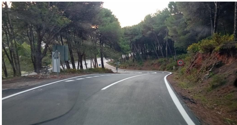
Recuperación estructural del firme y mejora del pavimento en carretera MA-5300, de A-355 a Juanar, Málaga (importe aprox. 500.000,00€)
