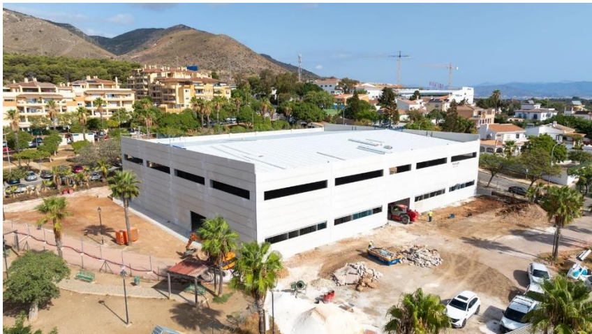
Ejecución del Pabellón Deportivo Cubierto El Palmeral en el Término Municipal de Torremolinos, Málaga (importe aprox. 1.300.000,00€)
