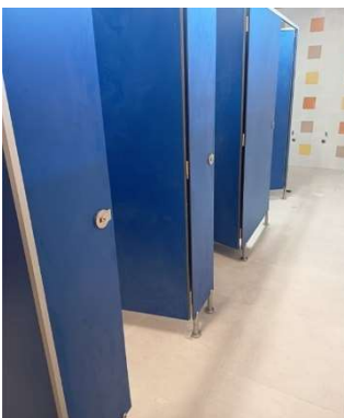
Antes-Después de Renovación de baños en CEIP Miguel Hernández, Málaga
