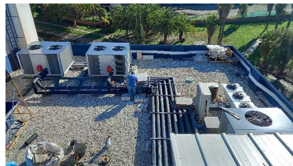
Instalación en cubierta - Edificio Sede Central
