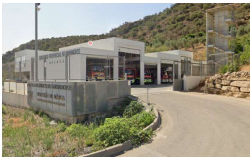
Parque de Bomberos de Coín, Málaga.
