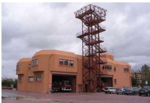
Parque de Bomberos de Málaga Zona 2.
