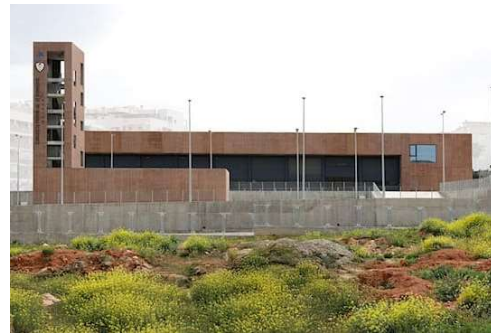
Parque de Bomberos de Antequera, Málaga.
